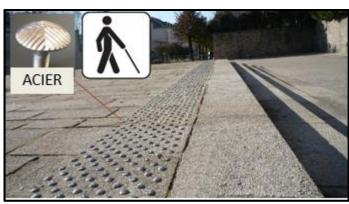
Figure 126: type de dispositif podotactile à utiliser.
