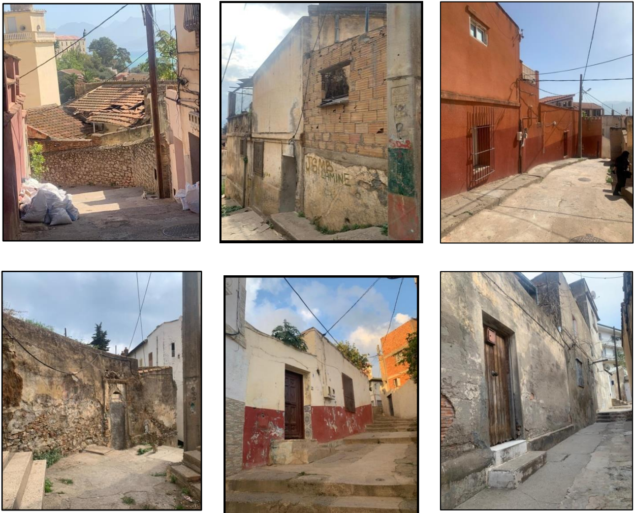
Figure 47 : ensemble de figures montrant l'état des bâtisses. Source : auteur, 2022
