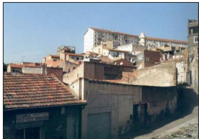
Figure 12 : Vue sur le quartier de Bab-el-Louze, Bejaïa.
