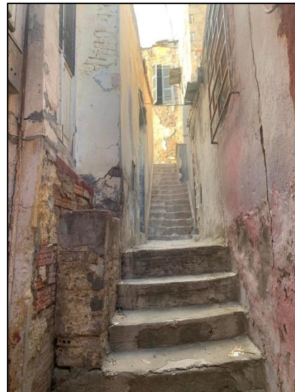
Figure 78 : L'escalier qui mène vers la maison Source : auteur, 2022
