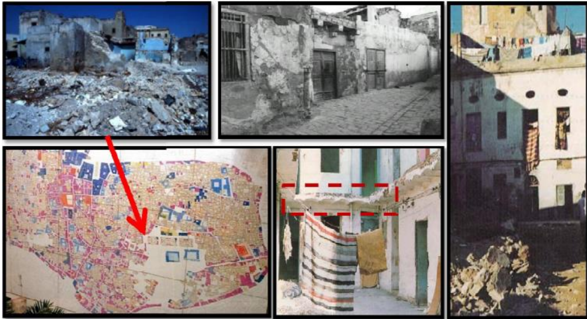
Figure 15 : photos des problèmes du site Source : (Othmani, Chabou, & Aissa, 2008)
