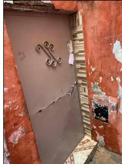
Figure 76 : l'accès principal de la maison Source : auteur, 2022
