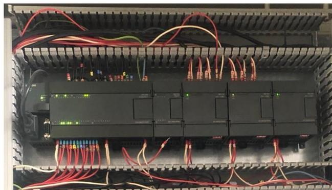
Figure I-13 : modules d'extension
