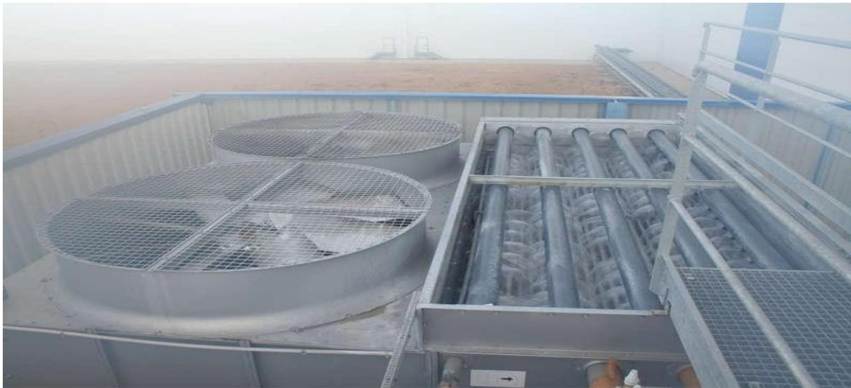
**Figure I.5:** Condenseur évaporatif.
