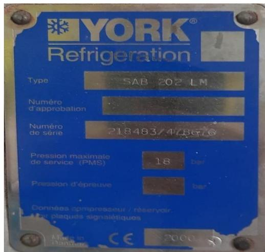
**Figure I.19:** Plaque signalétique de compresseur à vis SAB 202.
