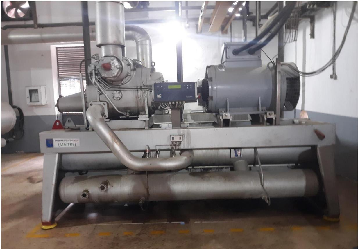
**Figure I.12:** Compresseur volumétrique rotatif à vis SAB 202.
