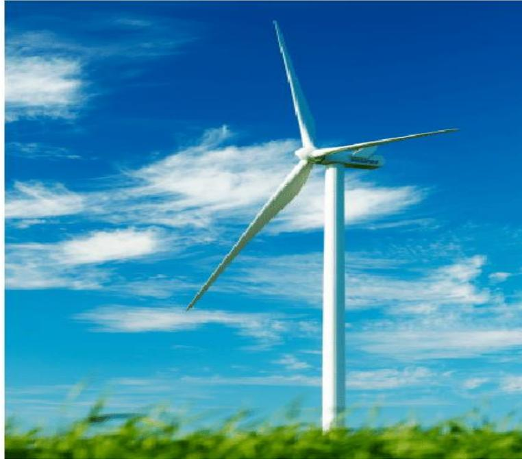
Figure I- 3:Éoliennes à axe horizontal [5]
