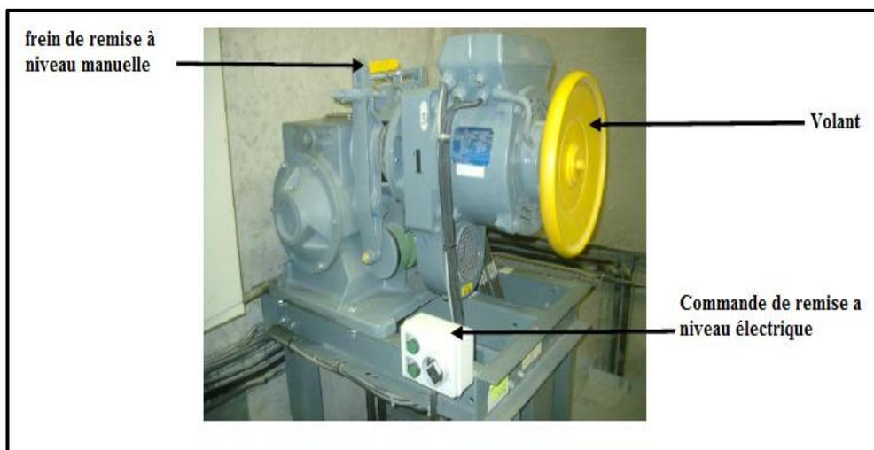
Figure III.13 : Machinerie ascenseur.
