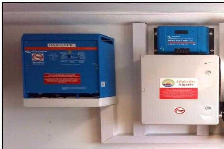
*Figure IV.8 : Onduleur et régulateur MPPT*
