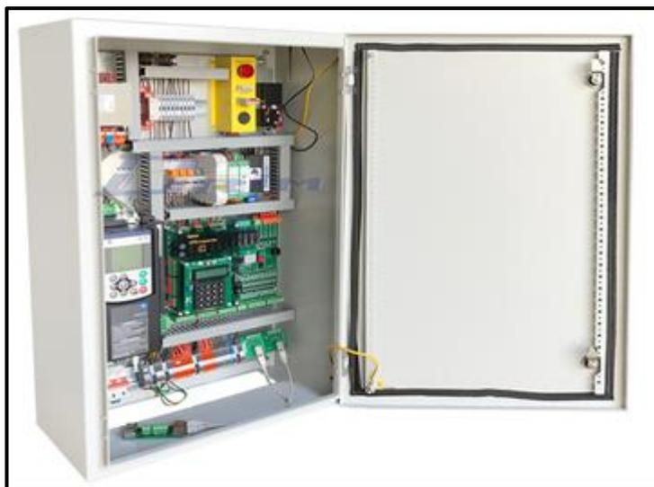
*Figure III.14 : Armoire de commande d'un ascenseur.*
