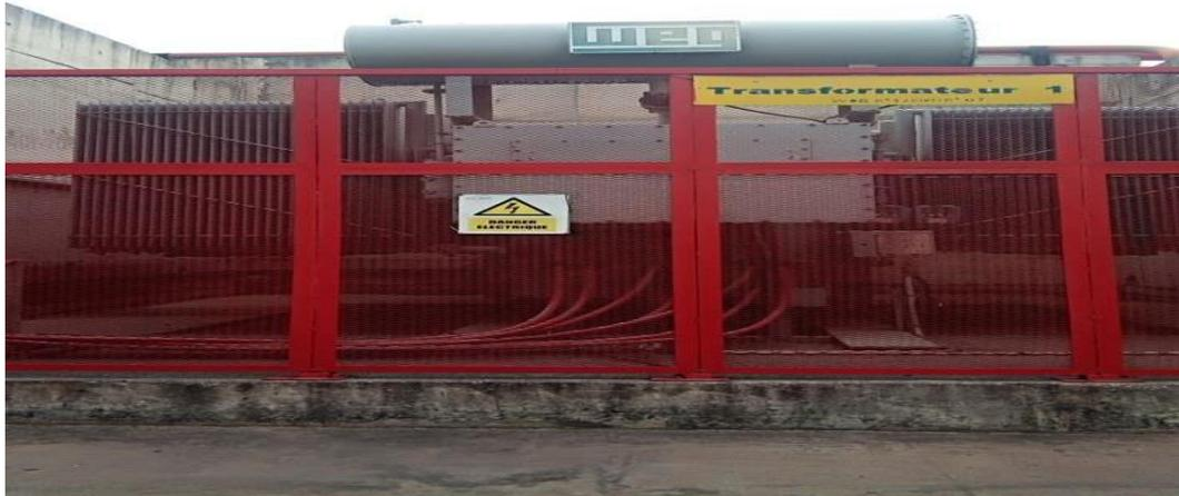
Figure II.1 : Transformateur T01 11/30KV
