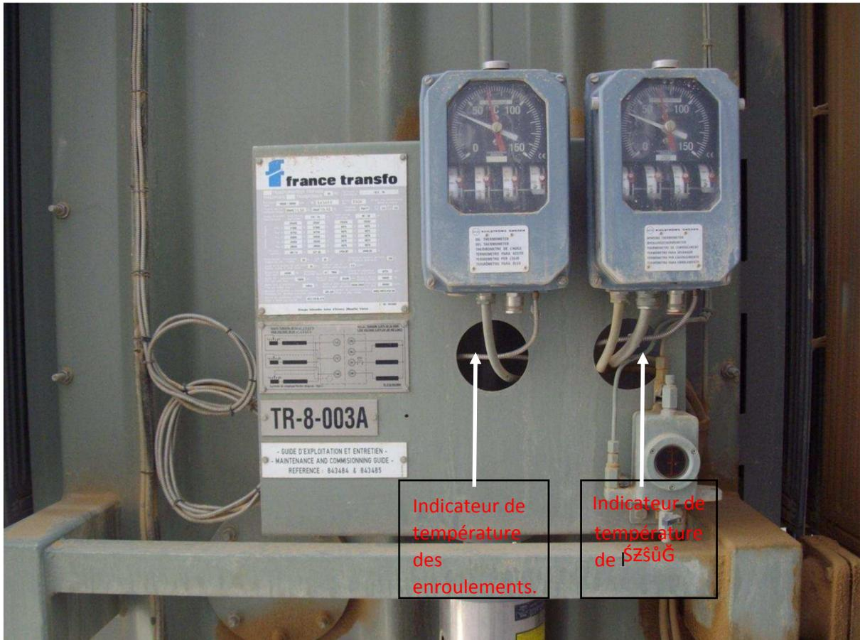
**Fig.I.15:** Les indicateurs de température du transformateur de puissance 25/30 MVA (TR-8-003A).
