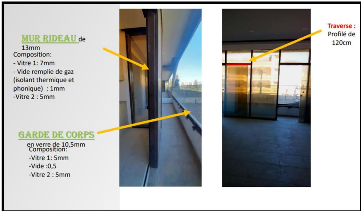
**Figure 71** Caractéristique du mur rideau, garde-corps et de la terrasse
