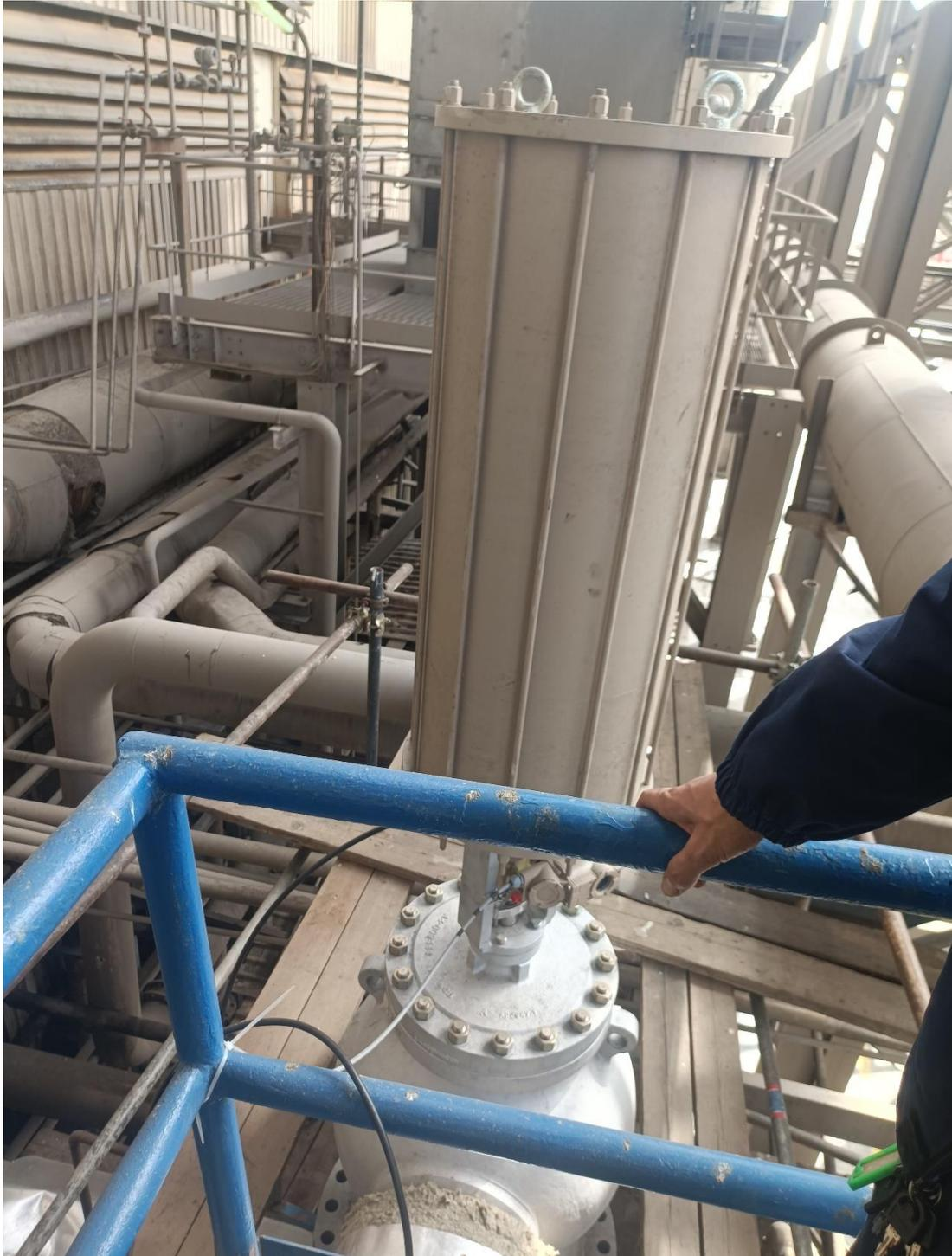
**Figure III-7 :** Vanne de régulation type 3595 avec le positionneur pneumatique Ex d type 3731-3 [10]
