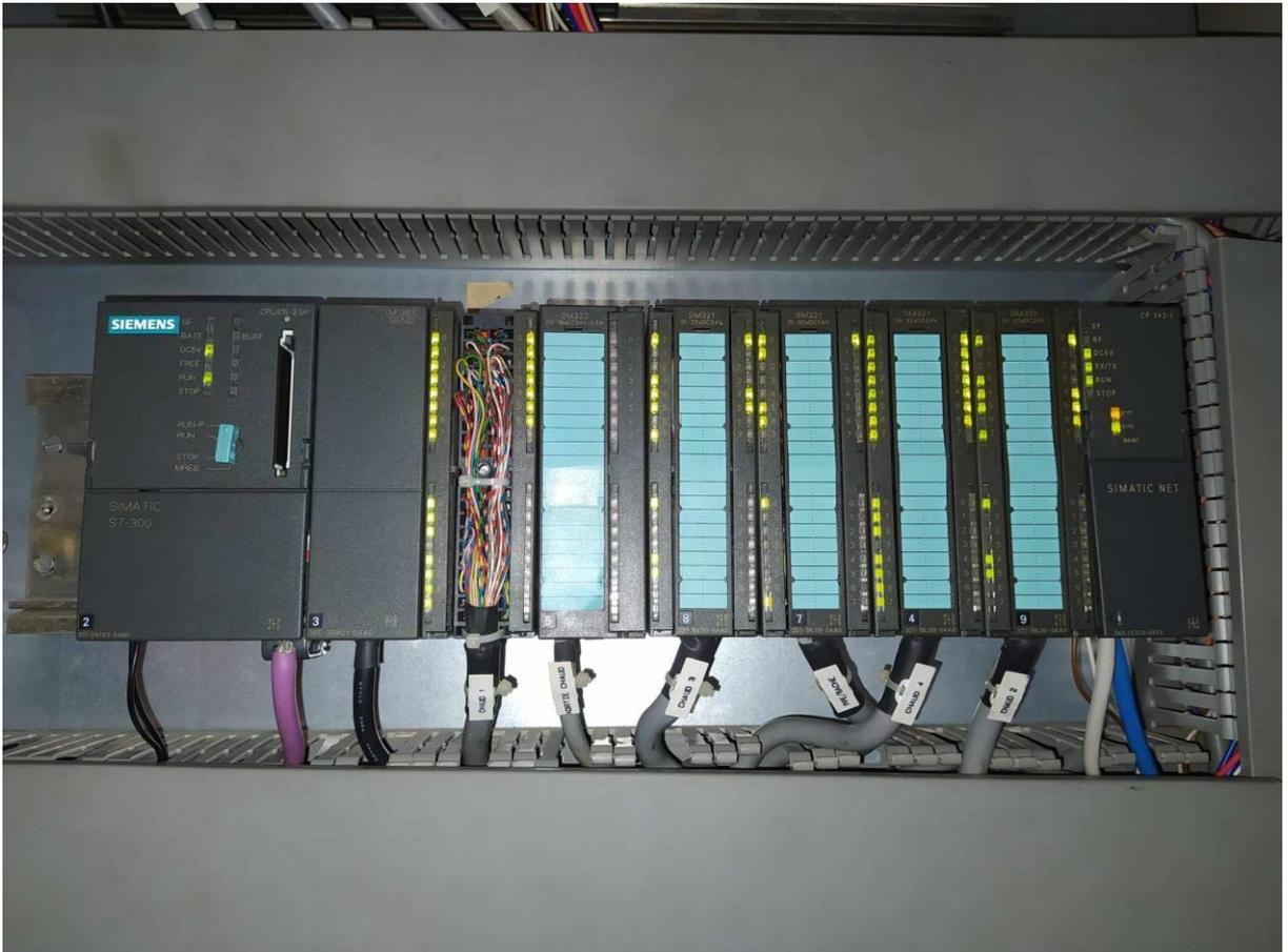
**Figure II-6 :** Automate modulaire SIEMENS utilisé à CEVITAL.[10]
