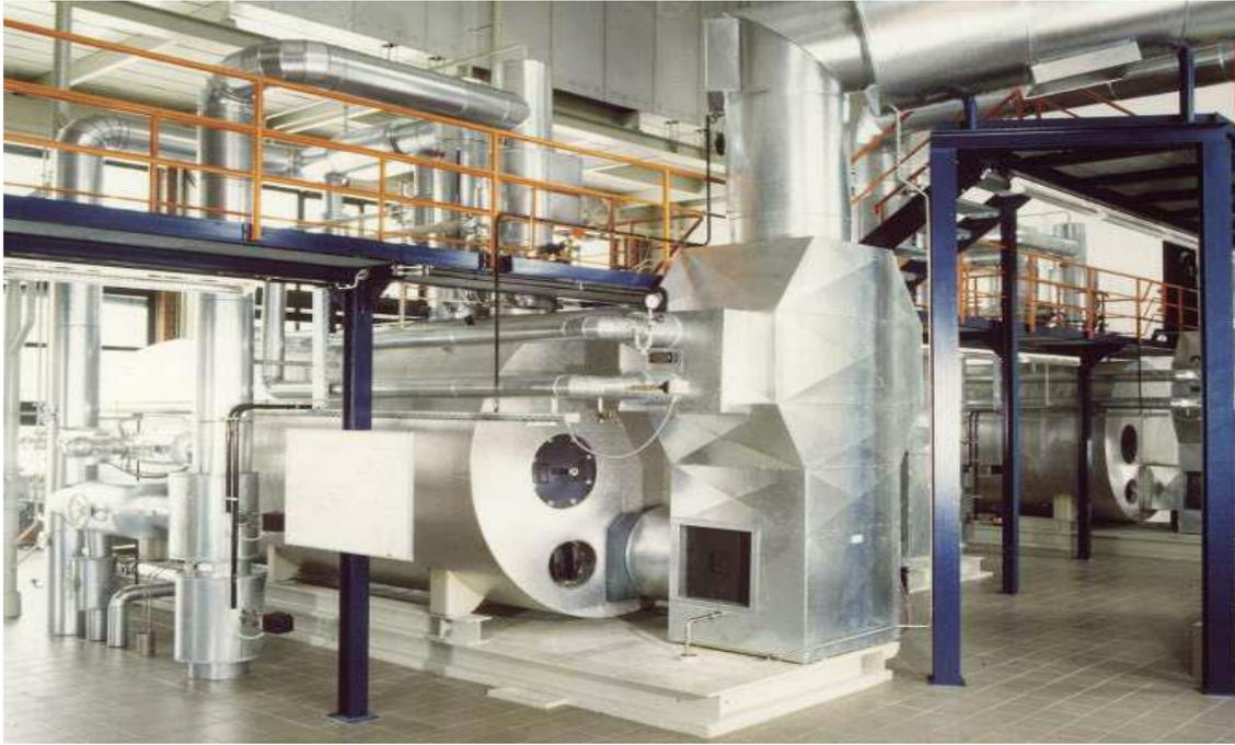
**Figure III-2 :** Chaudière à vapeur équipée d'un économiseur [5]
