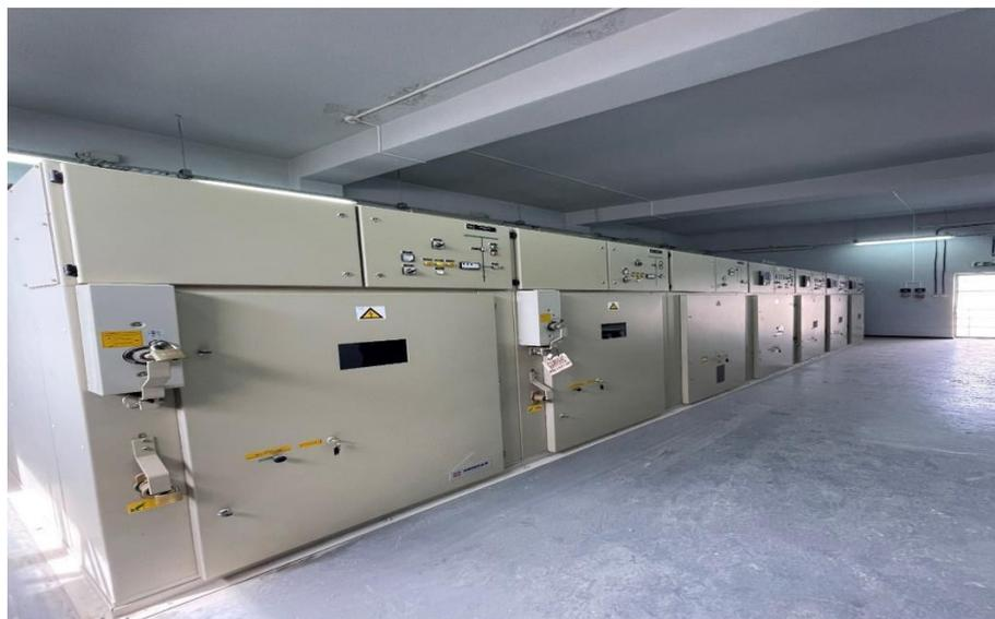
**Fig.II.1.** Poste de livraison existant – Tableau au 30kV
