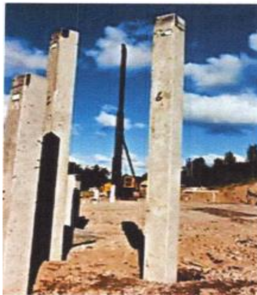
Figure I.12 : Pieu en béton
