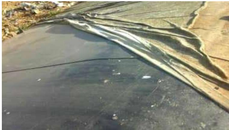
*Figure 20 : Géo membrane et géotextile (Originale, 2017)*
