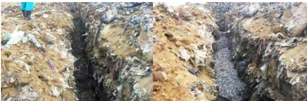
*Figure 21 : Réseau de drainage des lixiviats (Originale, 2017)*
