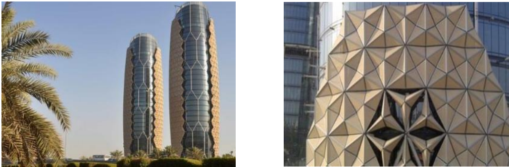
Figure 32: Façade interactive des Al Bahar Towers à Abou Dhabi. Source : https://www.archdaily.com
