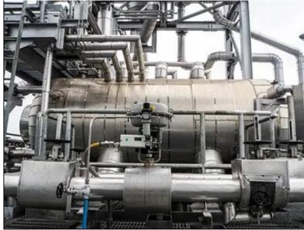
Figure I 4: Tambour de générateur de vapeur dans un system de chaudière à récupération de chaleur
