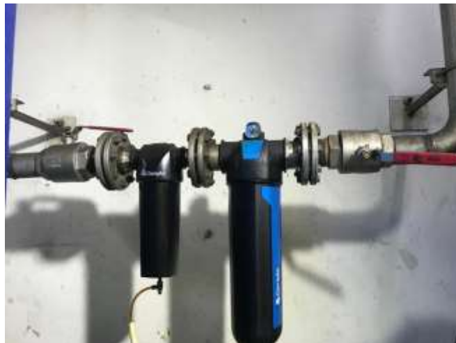
FigureII.3 : Déshuileur et filtre à air.
