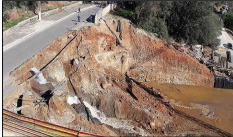
Figure I.20. L'effondrement d'un mur de soutènement (Bouzaréah).
