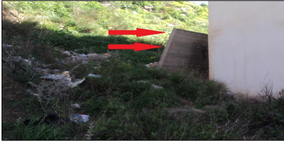
Figure III.7. Renversement du mur soutènement.
