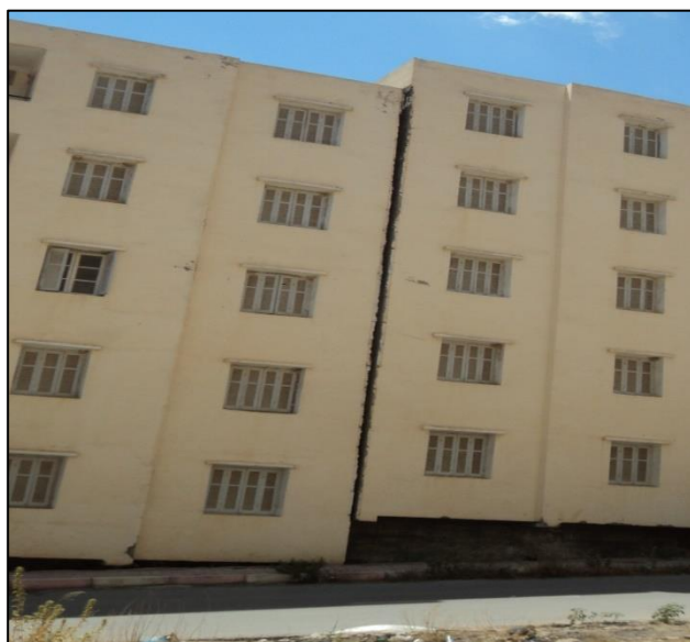
Figure III.4. Ouverture du joint de dilatation de deux blocs.
