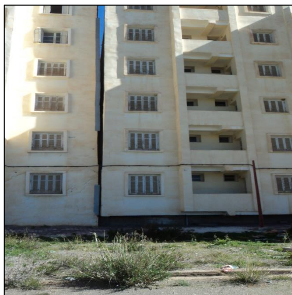
Figure III.4. Ouverture du joint de dilatation de deux blocs.
