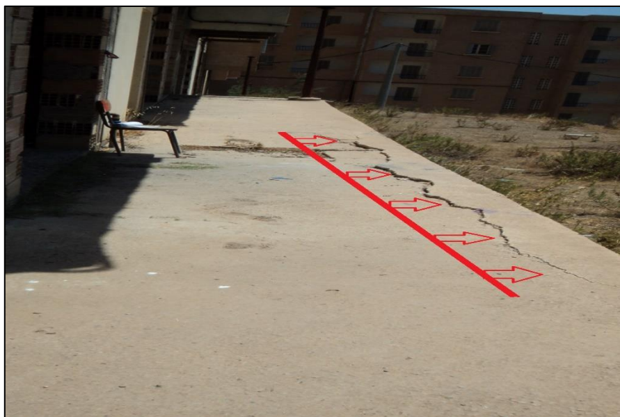
Figure III.6. Fissure et rupture d'un trottoir.
