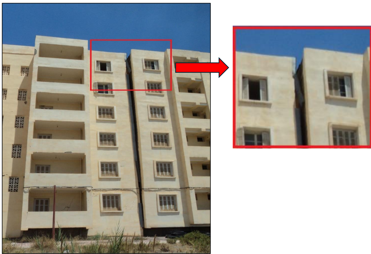
Figure III.5. Ouverture du joint de dilatation de deux blocs.
