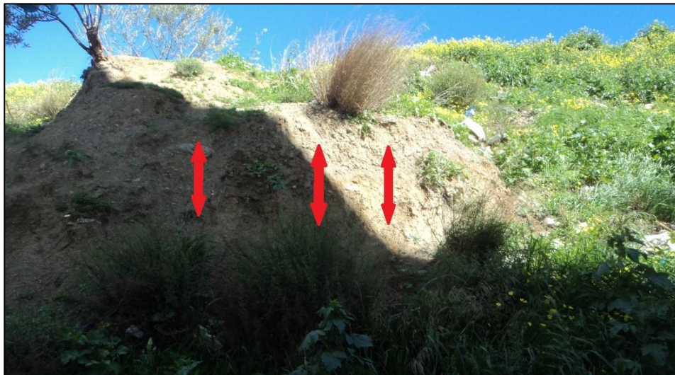
Figure III.8. Escarpements au niveau du talus aval.
