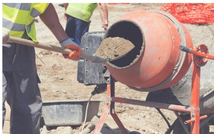
Figure.I.21 : La préparation mécanique de mortier.
