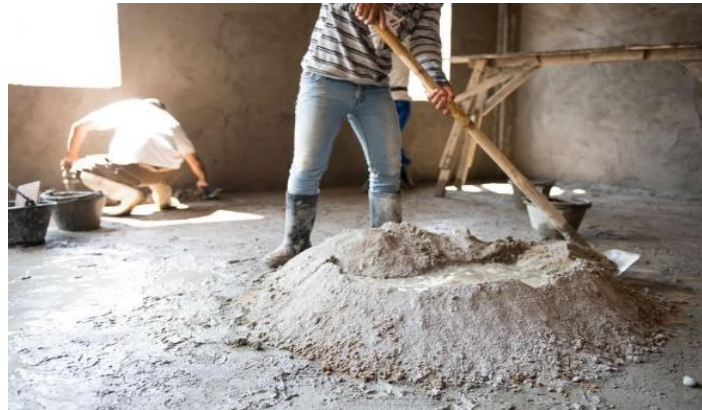
Figure.I.20 : La préparation manuelle de mortier.
