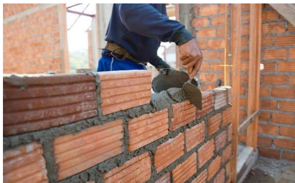
Figure.I.15 : hourdage de maçonnerie.
