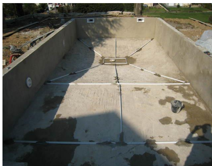
Figure.I.8 : La chape au mortier hydrofuge de la piscine.
