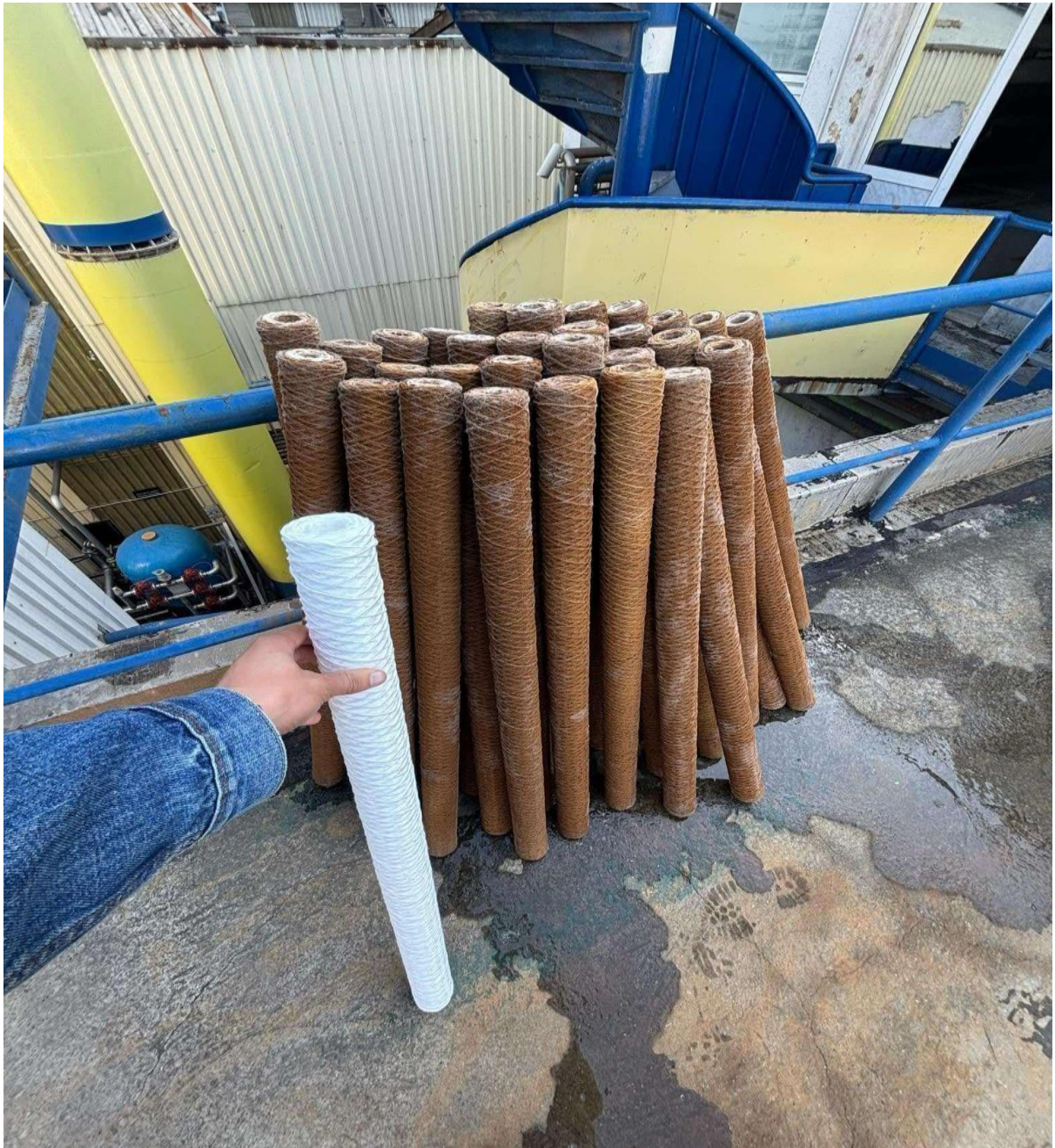
Figure 12: Les cartouches filtrantes bobinées (prise par nous durant la période de stade du 18/02 2025 Au 05/03/2025)
