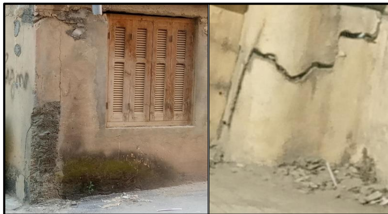
Figure 69: Facteurs d'humidité : infiltrations et détérioration des matériaux (Source : Auteur, 2025)
