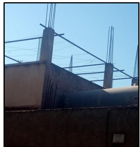
Figure 65: Corrosion des armatures (Source : Auteur, 2025)
