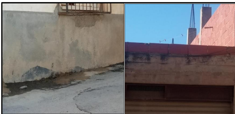
Figure 66: Détérioration des structures par l'eau et l'humidité (Source : Auteur, 2025)
