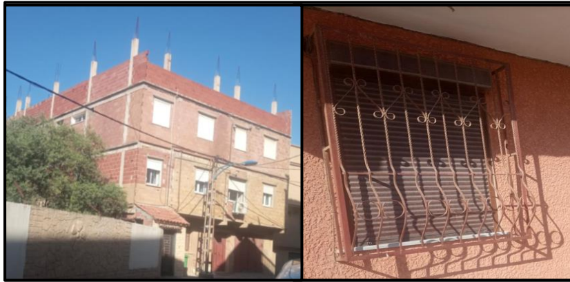
Figure 62: Oxydation des aciers dans les façades inachevées (Source : Auteur, 2025)
