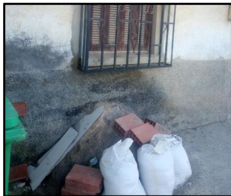
Figure 63: Problèmes d'étanchéité sous la fenêtre (Source : Auteur, 2025)
