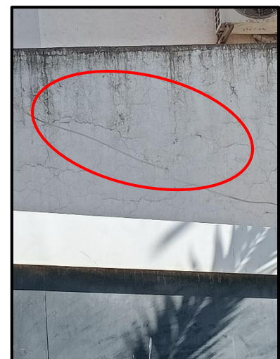
Figure 51 : Fissures en façade Source : Auteur, 2025
