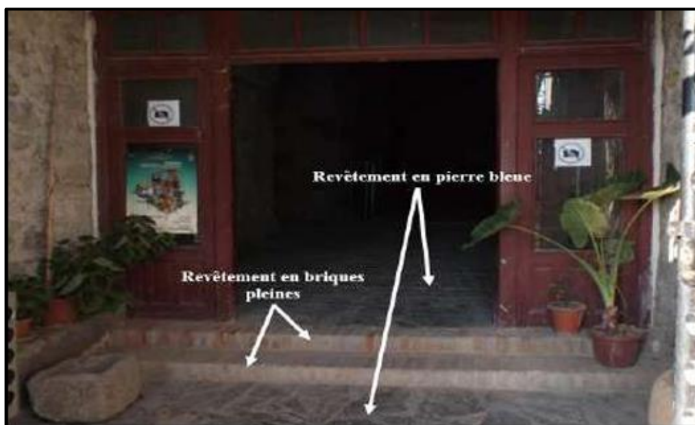
Figure 107 : Revêtement en brique pleine et pierre au niveau du sas (Source : auteur, photographiée le 24/04/2025).
