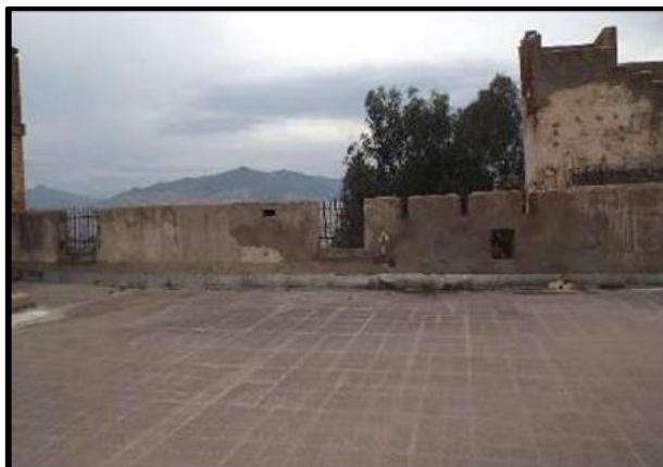
Figure 111 : Revêtement en carreaux de granito au niveau de la terrasse (Source : Photo prise par l'auteur 24/04/2025).
