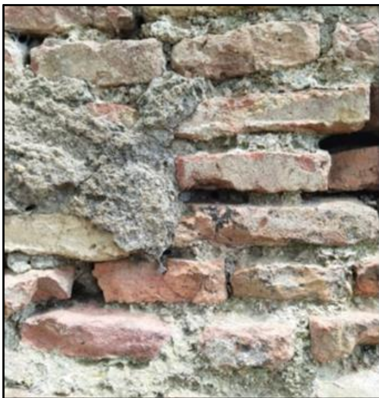
Figure 103 : Vue sur l'appareillage d briques liées par le mortier de chaux (Source : Photo prise par l'auteur 24/04/2025).
