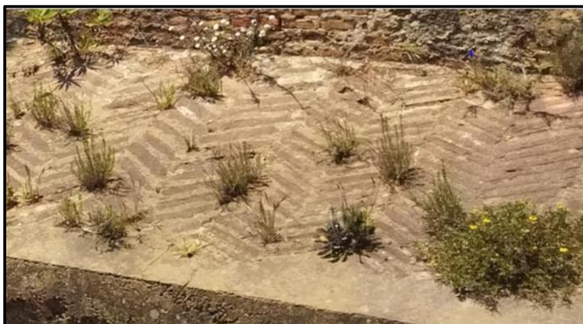
Figure 109 : Vue sur le revêtement en brique de terre cuite posé en épis de poisson (Source : Photo prise par l'auteur 24/04/2025).
