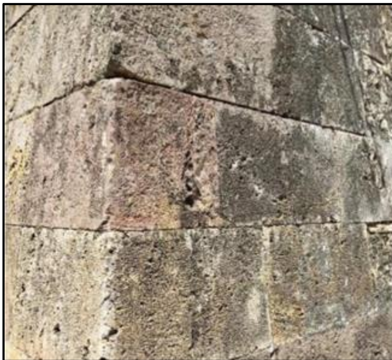
Figure 102 : l'assemblage de pierres quadrangulaires au niveau de l'angle sud-est (Source : Photo prise par l'auteur 24/04/2025).
