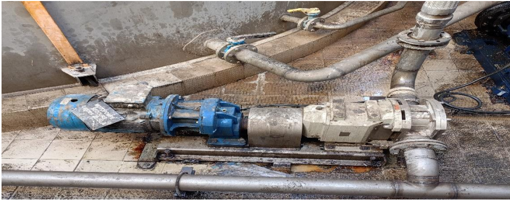
Figure I.2: Pompe d'alimentation huile pour remplisseur (photo prise en entreprise).
