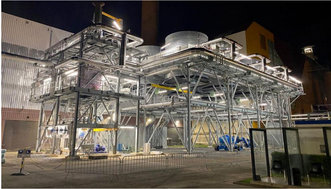
Figure I. 7 : L'Aérocondenseur.
