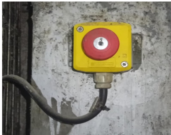
Figure II.9 : arrêt d'urgence à coup de poing.
