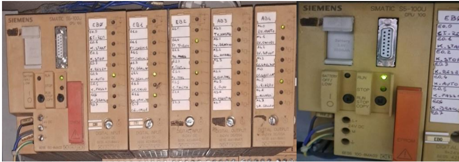
Figure 7 : Automate Siemens S5-100U chez CeVital.
