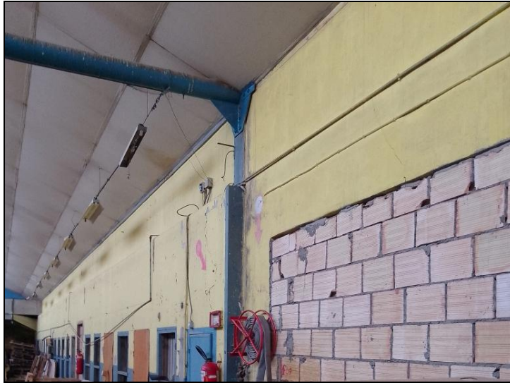
Figure 89 : image montrant le système structurel et de cloisonnement de l'usine ICOTAL, source : Photo prise le 08/01/2025
