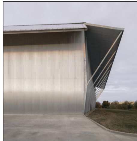
Figures 28 et 29 : Vues rapprochées sur le revêtement composite des façades et sur la toiture de la smart factory de Trumpf Hungary, source : archello.com
