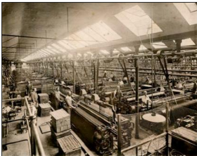
Figure 83 : Vue sur les ateliers montrant la pénétration de la lumière naturelle à travers des systèmes de sheds dans l'usine Balsan, source : bridgemanimages.com
