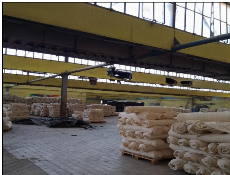
Figure 90 : image montrant le système de sheds Américain adopté dans l'usine ICOTAL, source : Photo prise le 08/01/2025
