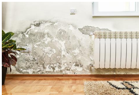
Figure 1.25: Altération des revêtements (Source : www.belmard-batiment.fr/ ).
