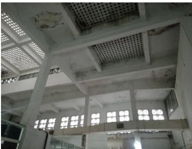
Figure 3.27 : Ouvertures zénithale Source : Auteur,2025.
