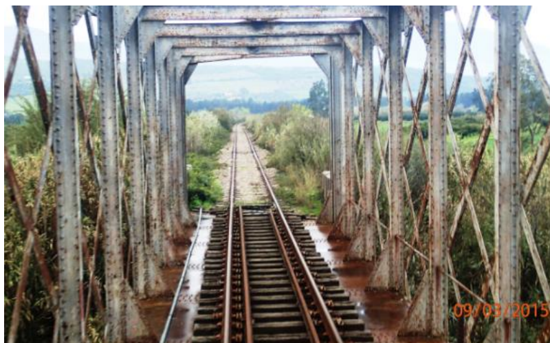
Photo 15-L'usure et corrosion des infrastructures-(Source : TPF - Projet de duplication de la ligne ferroviaire Beni Mansour - Béjaïa, https://tpf.pt/obra.php?s=ferrovias&p=duplicacao-da-linha-ferroviaria-beni-mansour-bejaia&lang=fr )
