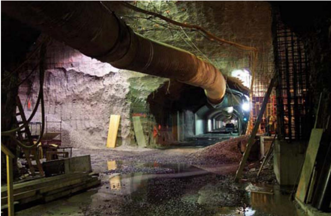
Photo 3- Ventilation et Eclairage des tunnels. (Source : Le métro de Laval – Aux grands maux, les grands moyens ! , Dossier, Société de transport de Montréal, adaptée par l'auteur)
