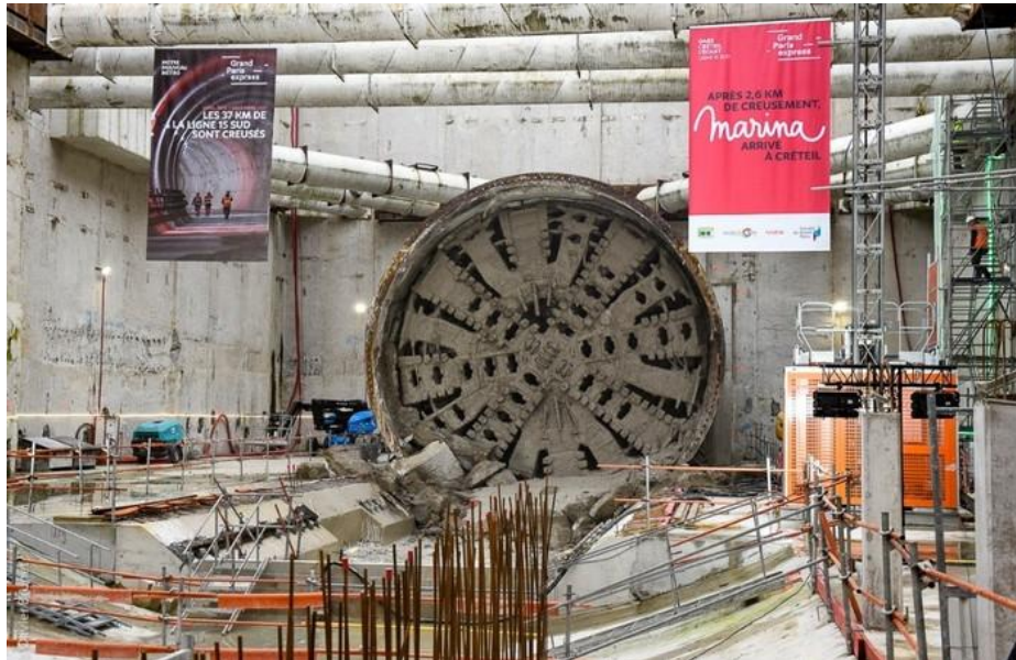
Photo 6- Derniers tours de coupe du tunnelier Marina. (Source : Grand paris express, Adapté par l'auteur)
