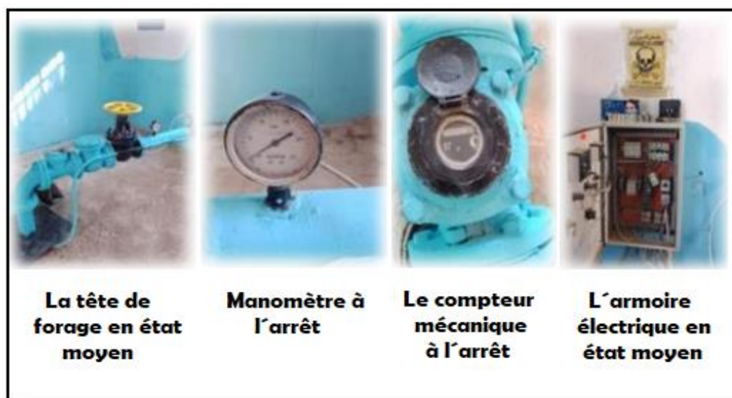
Figure (II-2) : L'état des équipements hydromécaniques du forage Ouled Bellil. [4]
