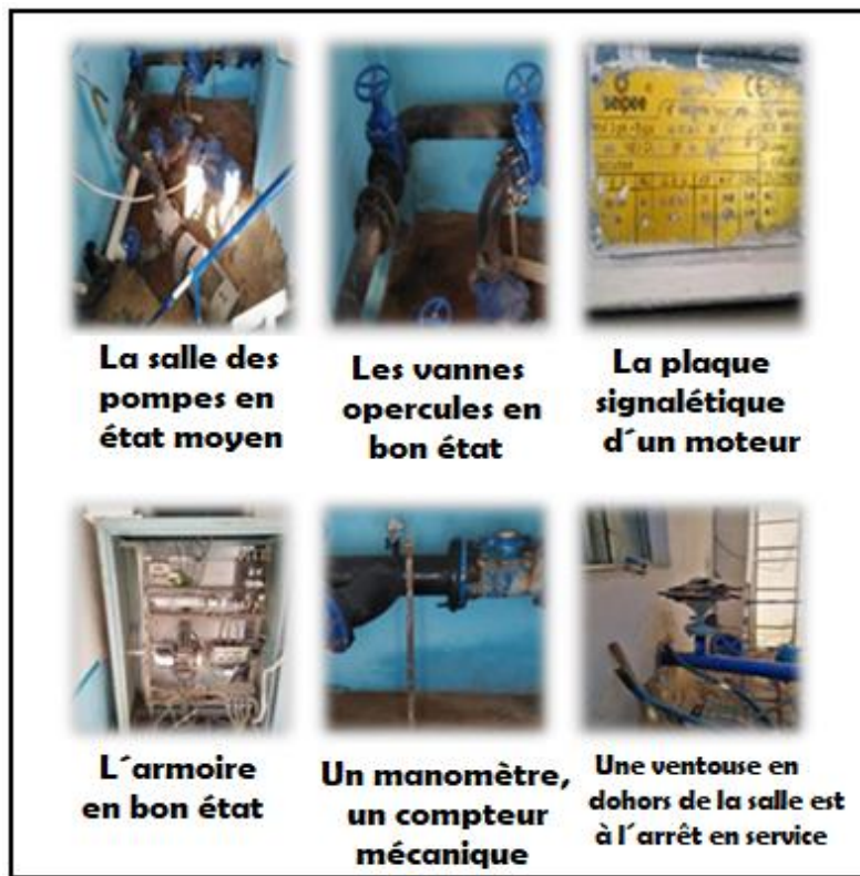
Figure (II-4) : L'état des équipements de la station de reprise SR d'Ouled Bellil. [4]
