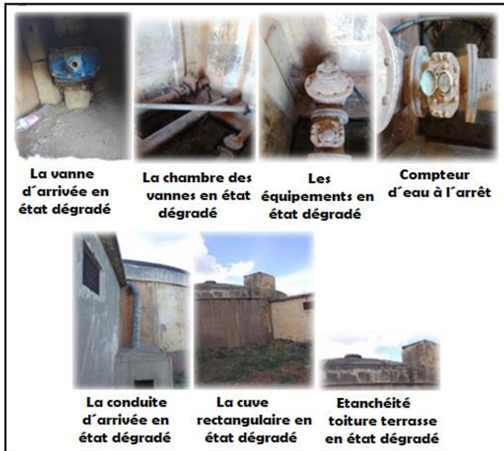
Figure (II-6) : L'état de G.C et des équipements du réservoir R500 m 3 Ouled Bellil. [4]
