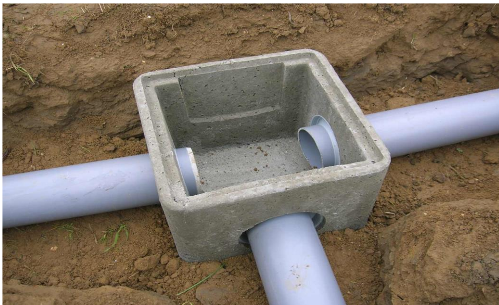
Figure II.6 : Regard préfabriqué enterré
