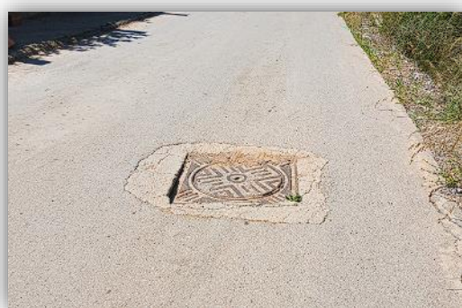
Figure I.8 : état des regards de tronçon trouvé
