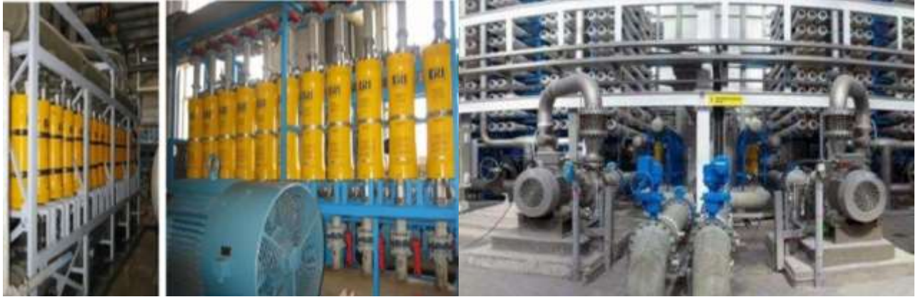
Figure III. 3. Emplacement des échangeurs de pression ainsi que les pompes booster
