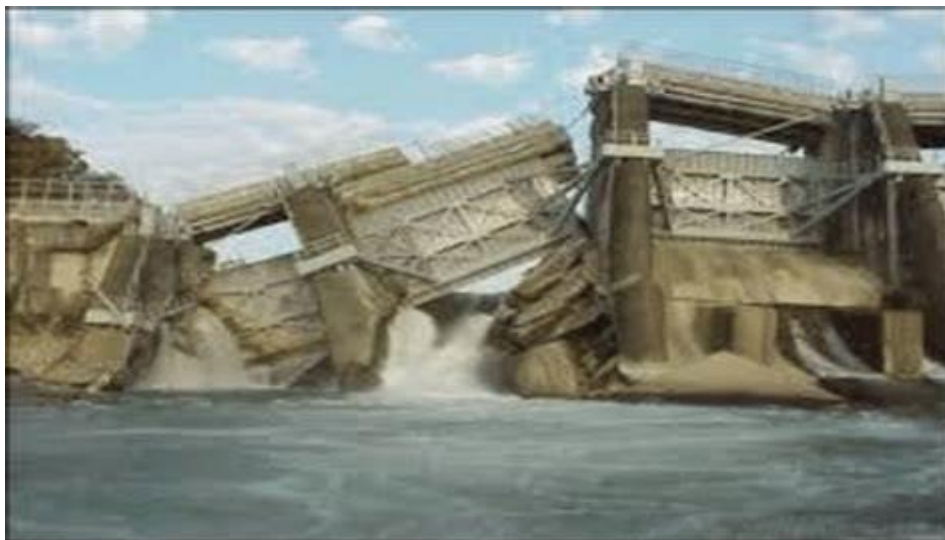
Figure 11 : Barrage de Shih-Kang après le séisme Chi Chi (Taïwan) [12].
