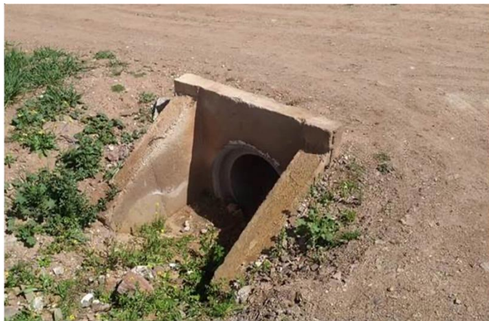
Photo IV-1 : Ponceau de forme circulaire.
