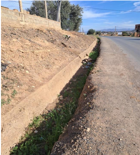
Photo IV-2 : Caniveau Obturé par dépôts de Végétation à l'amont de dalot.
