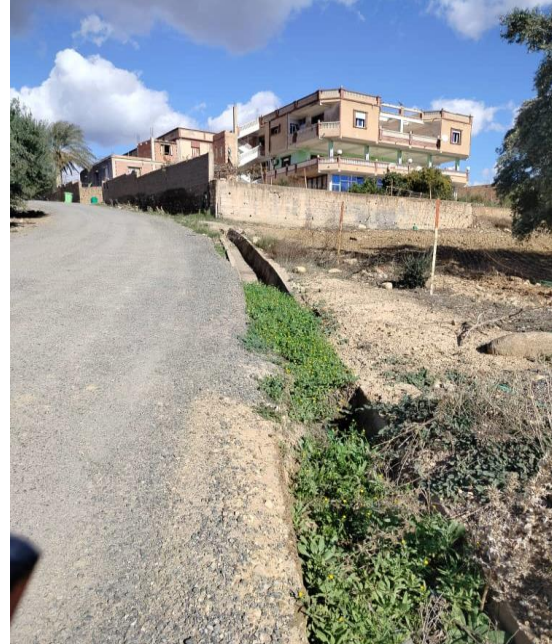
Photo IV-3 : Caniveau Obturé par dépôts de terre et Végétation à l'amont de dalot.
