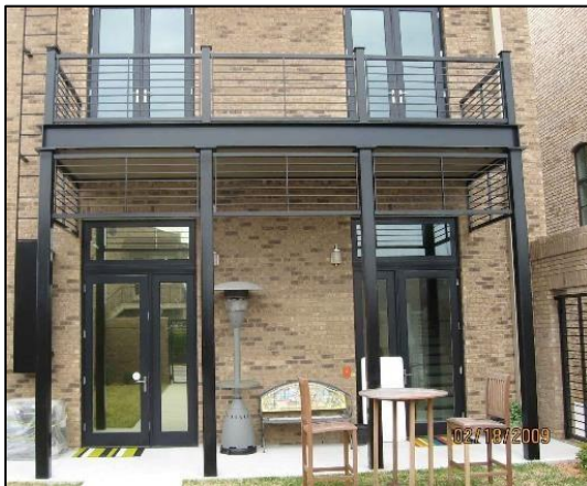
Figure 28 : Balcon avec structure métallique séparé de la construction source : Pinterest
