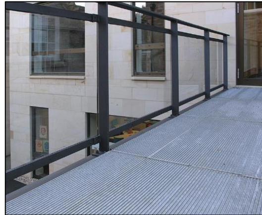
Figure 29 : balcon en caillebotis en acier galvanisé source : www.archiexpo.fr , consulté : le 2/04/2024
