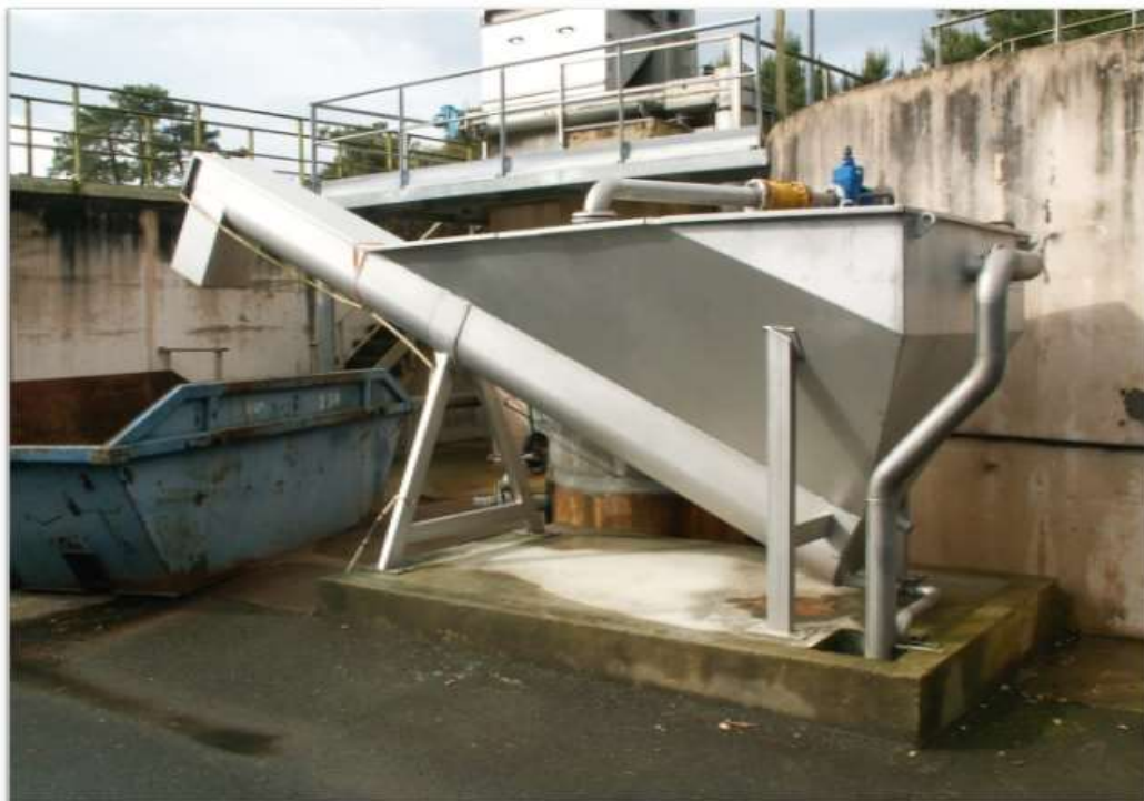
Figure (II.6) : Classificateur à sable [14].
