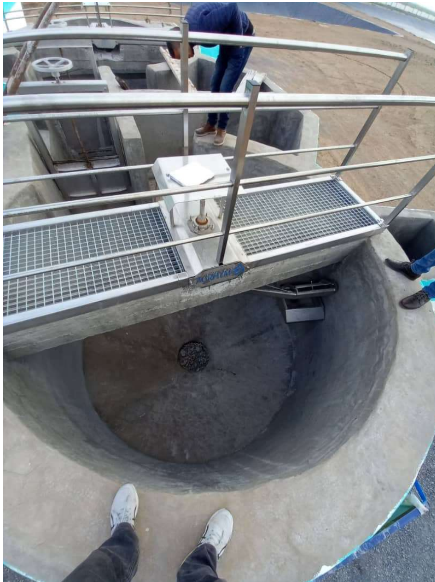
Figure (II.5) : Pont racleur en inox 02.
