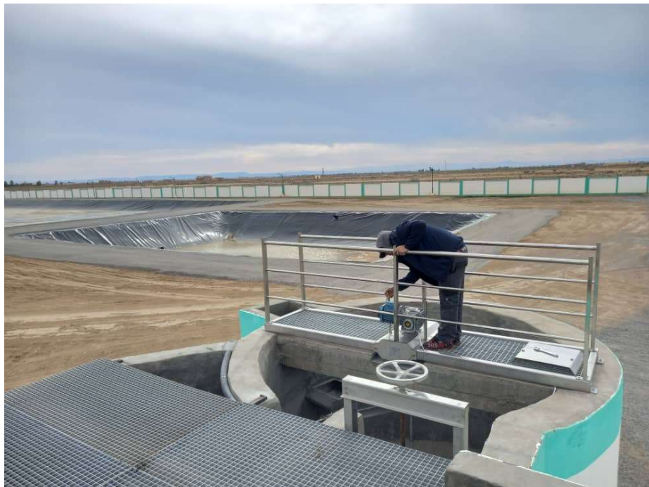
Figure (II.4) : Pont racleur en inox 01.
