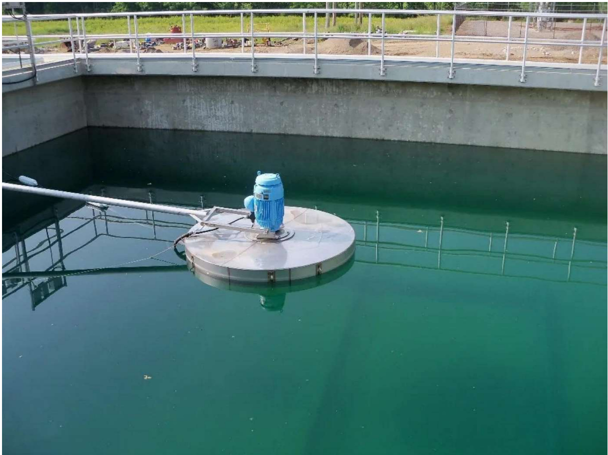
Figure (II.7) : Aérateur à soufflante [16].
