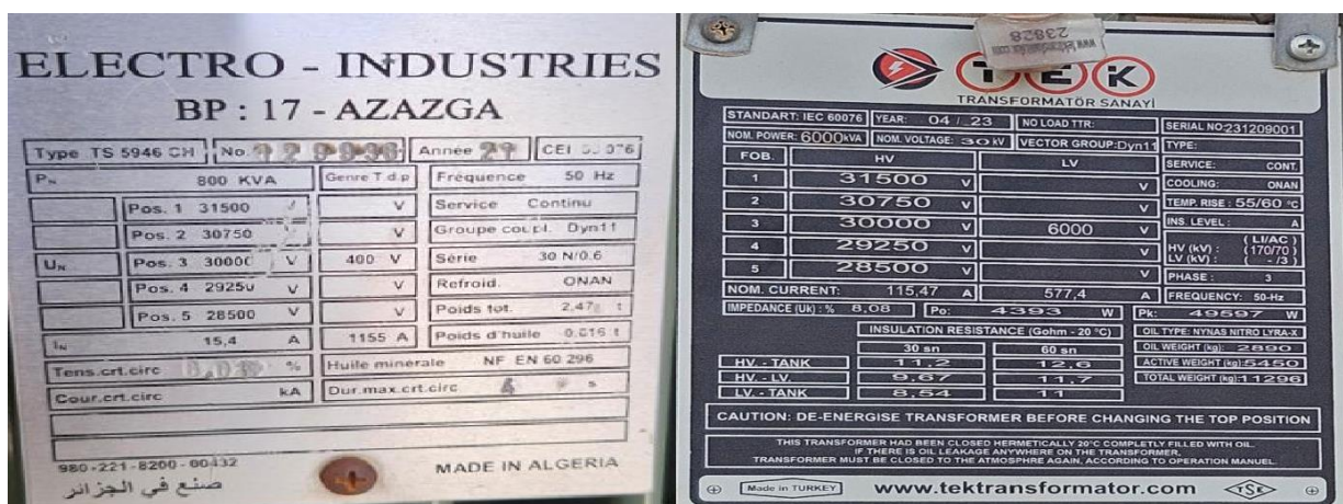
Figure III.2: Plaques signalétiques des deux transformateurs de puissance
