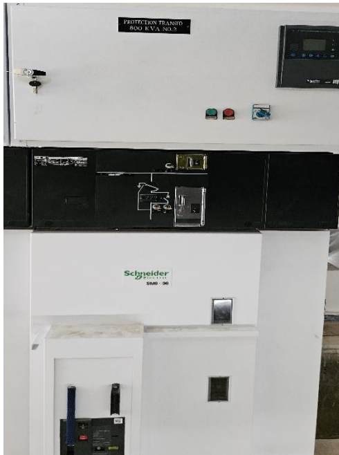
Figure III.3: Relais de protection des deux transformateurs 800 kVA et 6 MVA
