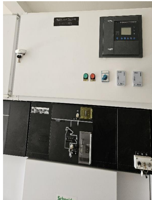
Figure III.3: Relais de protection des deux transformateurs 800 kVA et 6 MVA
