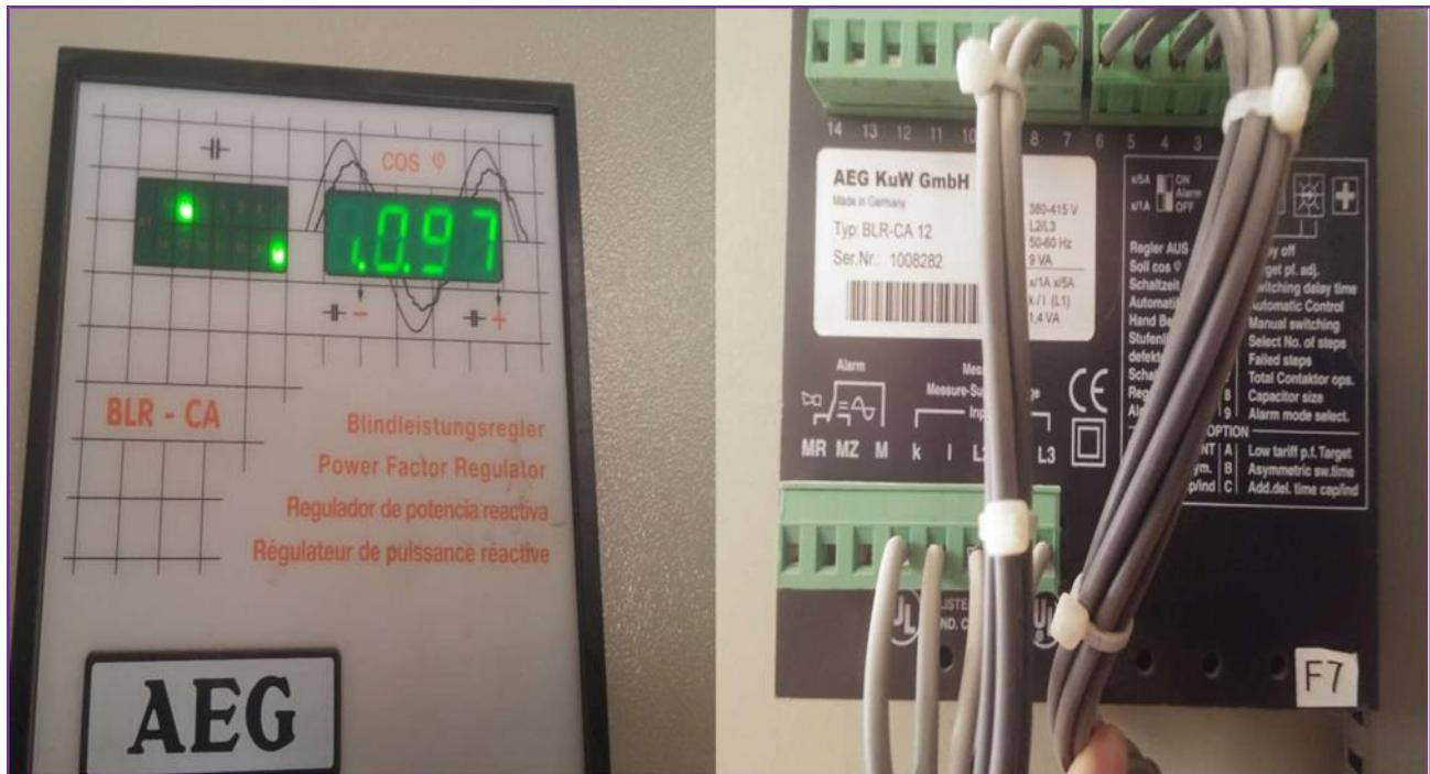
**Figure III. 14 : Régulateur varmétrique [10].**
