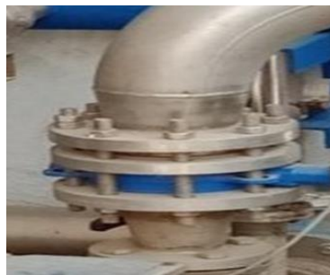
Figure I.15: Clapet utiliser dans la station
