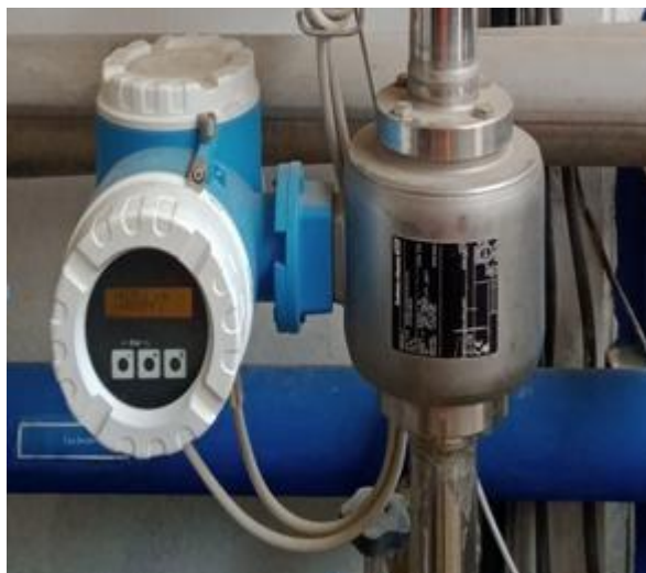
Figure I.8: Débitmètre électromagnétique utilisé dans la station
