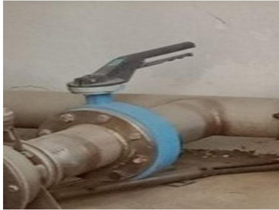
Figure I.13 : Vanne manuelle utiliser dans la station
