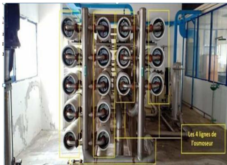
Figure I.4 : Photos des 4 lignes de l'osmoseur à osmose inverse
