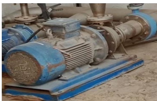
Figure I.12 : Pompe centrifuge utiliser dans la station
