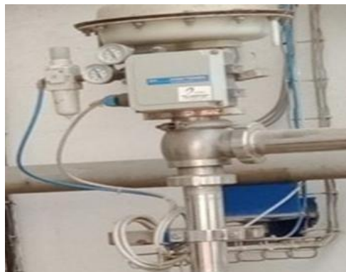
Figure I.14 : Vanne modulante utiliser dans la station
