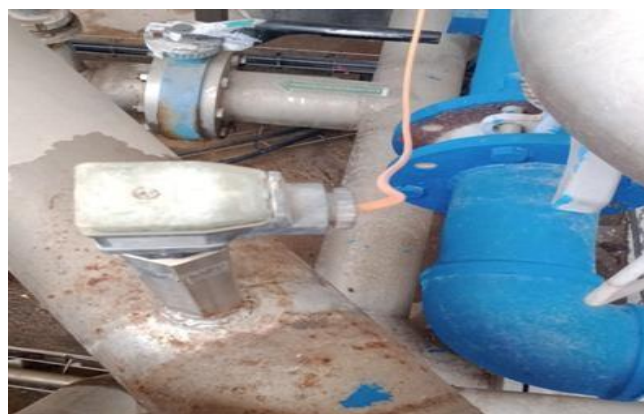
Figure I.10 : Sonde de conductivité
