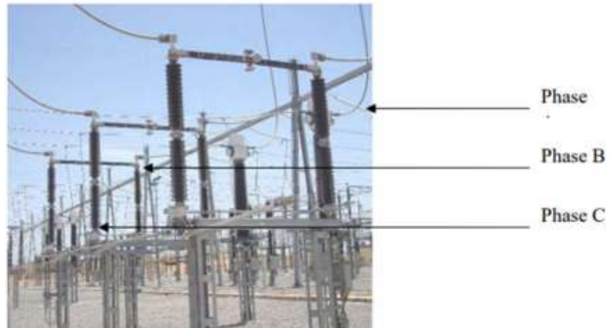
Figure. I.17. Sectionneur de ligne. [15]
