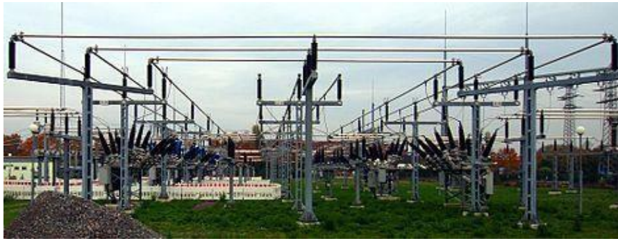
Figure II.3 : Image d'un jeu de barre HT aérien de profilé O et en configuration U
