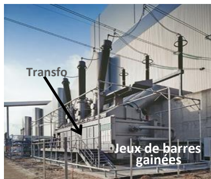
Figure II.4 : Images de jeux de barres MT préfabriqués faisant la liaison entre alternateurs et transformateurs.
