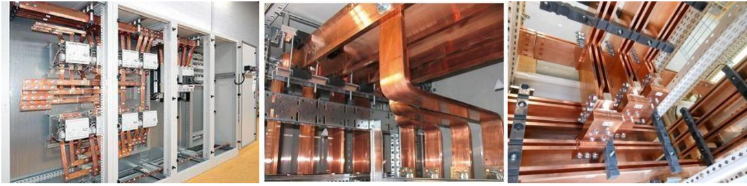
Figure II.5: Images de quelques configurations de jeux de barres BT (TGBT) de profilés I
