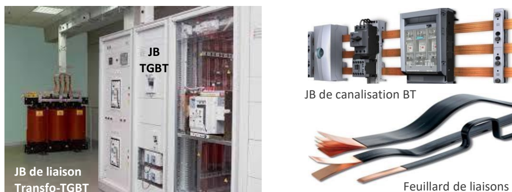
Figure II.2 : exemples d'utilisation des jeux de barre de distribution BT
