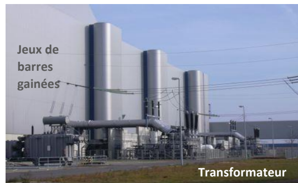
Figure II.4 : Images de jeux de barres MT préfabriqués faisant la liaison entre alternateurs et transformateurs.
