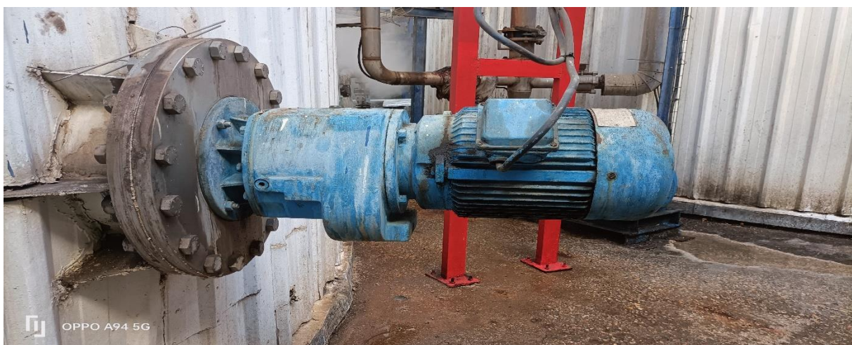
Figure I.4 Moteur d'un agitateur
