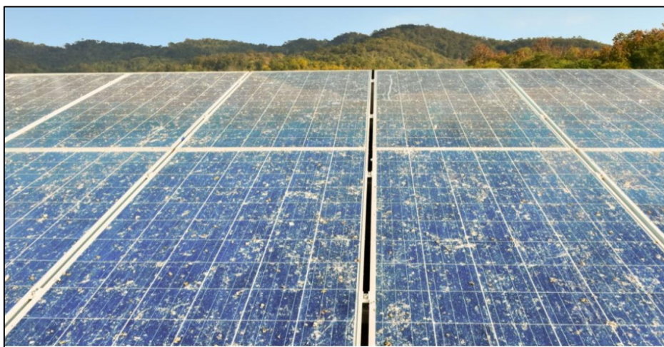
Figure III.1: Exemple d'encrassement d'un générateur PV [28].
