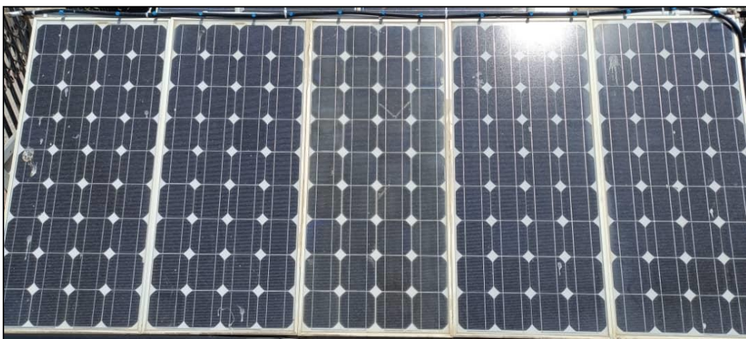
Figure III.14: Générateur PV encrassé.
