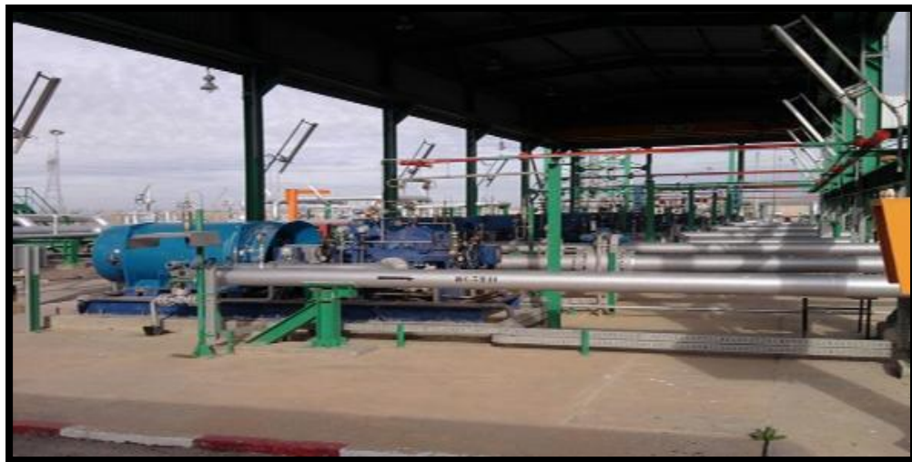
Figure 1.8 : Disposition des électro- pompes principales GEP A, B, C, D et E
