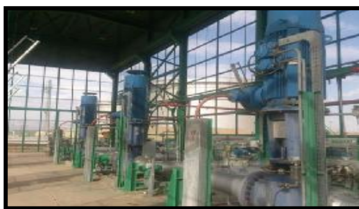
Figure 1.6 : Pompes booster A, B et C
