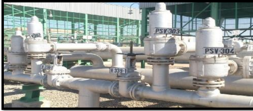
Figure 1.9 : Soupapes de décharges PSV 303 et 304
