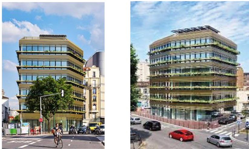
Figure II-15: l'immeuble de bureau « les horizons » à Paris (Source : https://conseils.xpair.com ).
