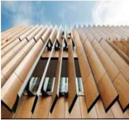
Protection solaire verticale « A »
