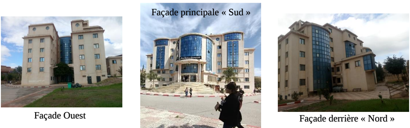
Figure III-10 : les différentes façades de bloc des enseignants de Compus Targa Ouzemmour (source : auteur, 2023).
