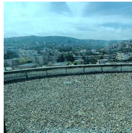
Figure III-14 : l'étanchéité de la toiture (source : auteur, 2023).
