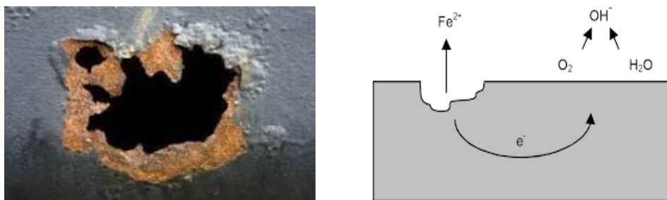
Figure I.13 : Corrosion par piqure (Corrosions par piqûres dans les tuyaux métalliques - Causes et solutions, 2025).
