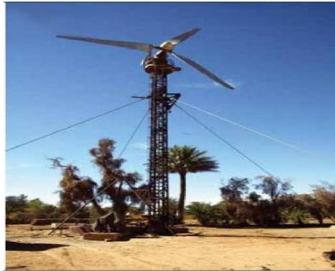
Fig. I-3 : Première éolienne de pompage installée en 1953 à Adrar [6]
