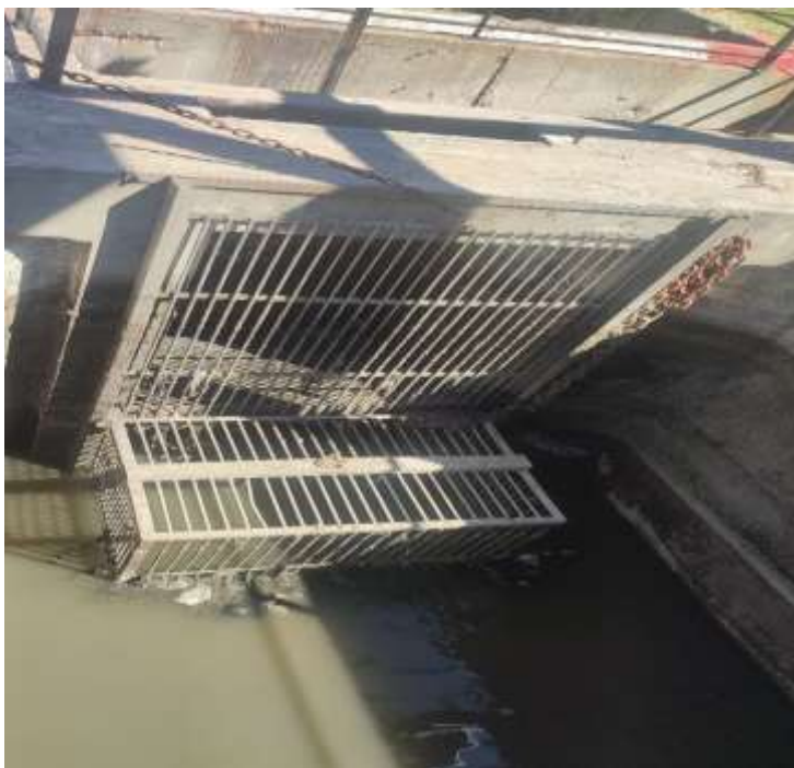
Figure 2.2 : pré-dégrilleur
