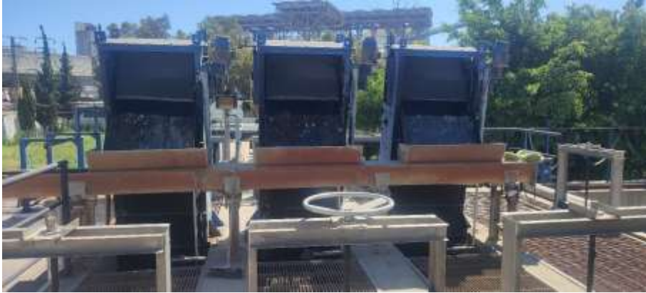
Figure 2.3 : Grille automatique
