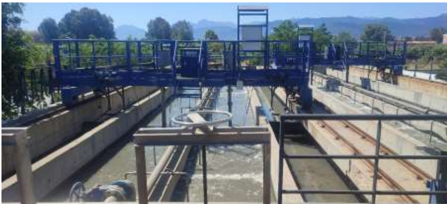
Figure 2.4 : Dessablage-déshuilage
