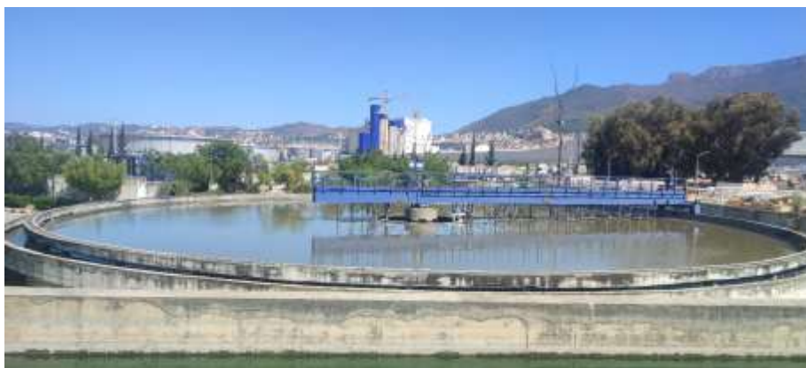
Figure 2.6 : Clarificateur
