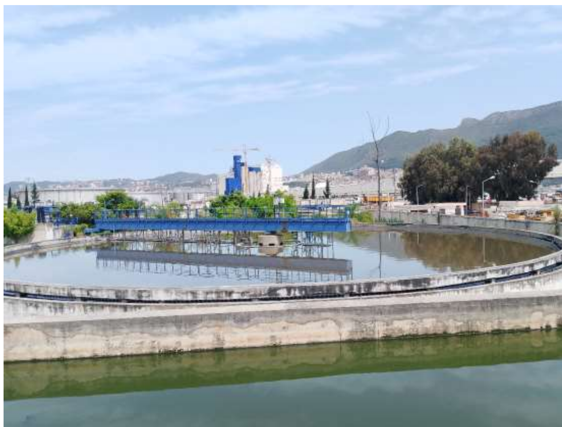
Figure II.7 : Photo représentant le clarificateur
