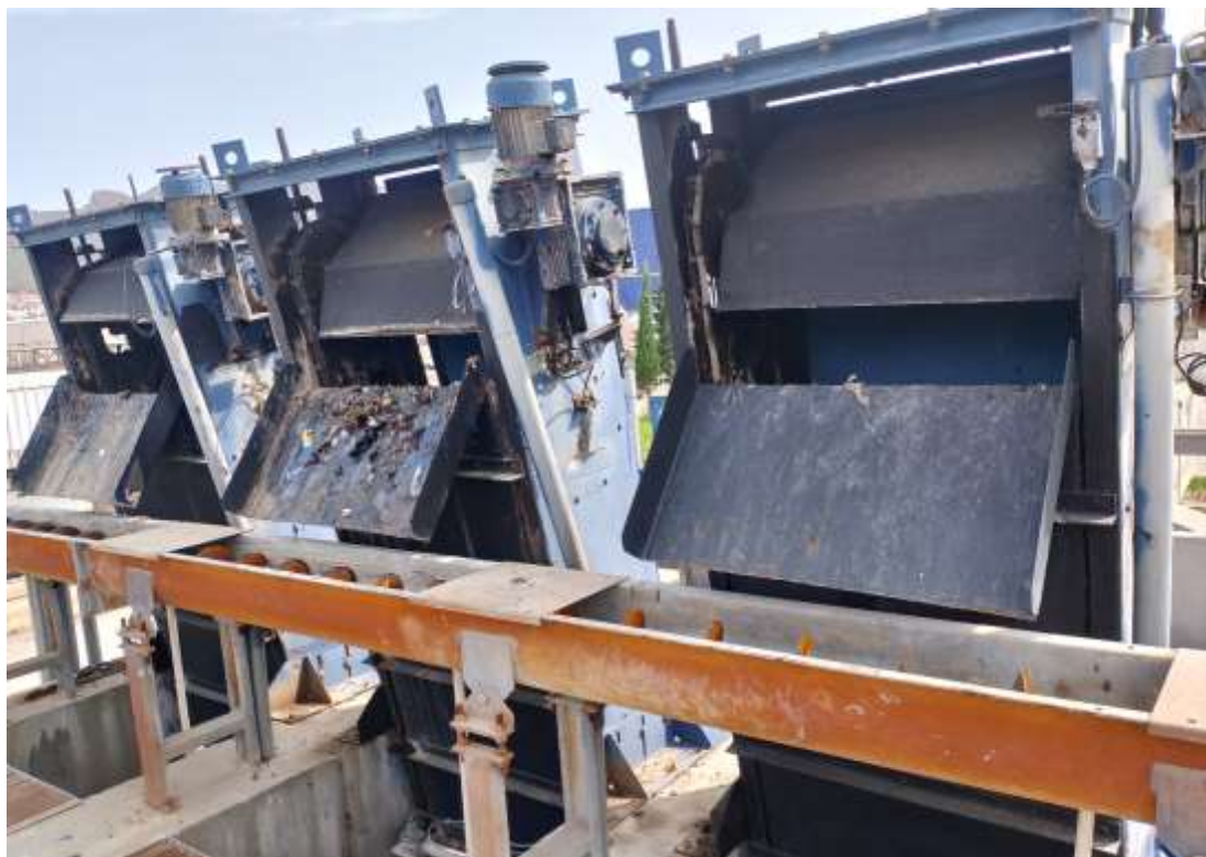
Figure II.4 : Photo représentant une grille séparatrice de déchets fins
